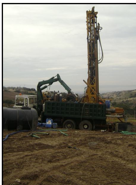
Εικόνα 40. Εξόρυξη νέας γεώτρησης στην Γ' ζώνη προστασίας.
