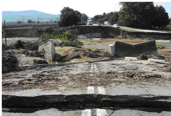
Σχήμα 3. Ένα χαρακτηριστικό παράδειγμα των καταστροφών που προκλήθηκαν ήταν αυτή της γέφυρας κοντά στον οικισμό του Μοδίου. Μόνο η ανακατασκευή της γέφυρας αυτής, δύο χρόνια αργότερα, κόστισε 2,25 εκατομμύρια Ευρώ.
