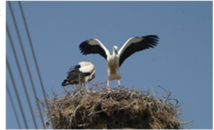
Εικ. 1. Φωλεοποίηση σε κολώνα της ΔΕΗ
