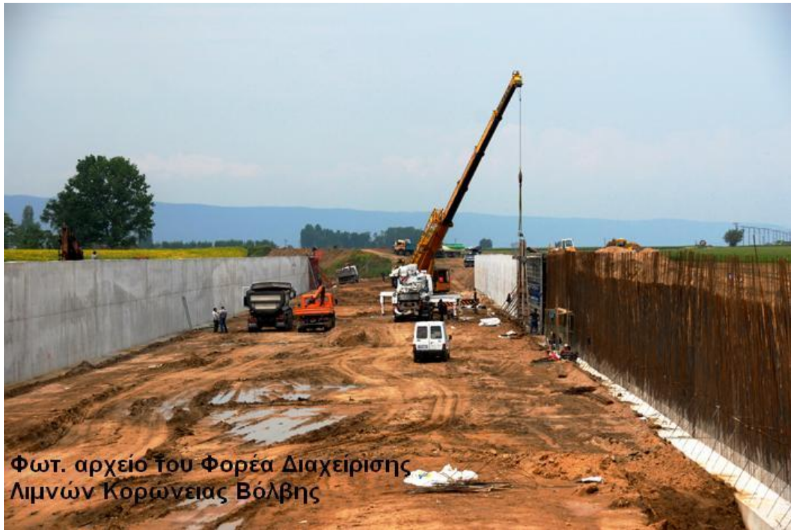
Εικόνα 5.5: Η κατασκευή της ενωτικής τάφρου (Πηγή: Φορέας Διαχείρισης Κορώνειας - Βόλβης)
