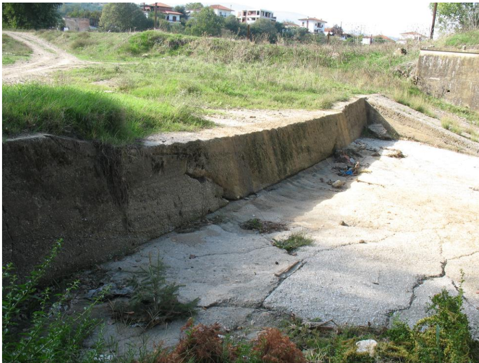
Εικόνα 22: Ύπαρξη τεχνητών αναβαθμών στο ρέμα της Γερακαρούς
