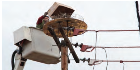
Εικόνα 5.1.21. Καθαρισμός φωλιάς με προστατευτικά αγωγών μέσης τάσης.
