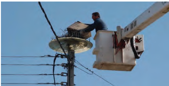
Εικόνα 5.1.20. Τοποθέτηση βάσης σε κολώνα στο Ηράκλειο του Δήμου Λαγκαδά.
