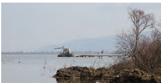
Εικόνα 5.1.9. Εξοπλισμός εξαγωγής της λάσπης από τον πυθμένα της λίμνης.
