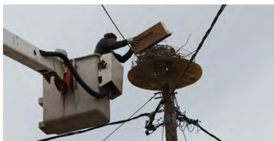
Εικόνα 5.1.19. Τοποθέτηση βάσης φωλιάς στην Ανάληψη.
