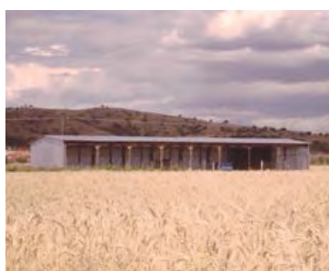
Εικόνα 6.1.14. Κατασκευή από ξύλο και λαμαρίνα στην περιοχή του Ευαγγελισμού.
