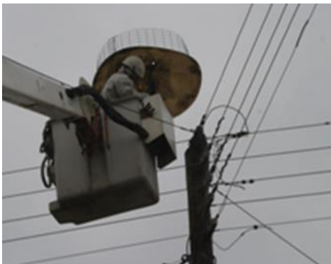
Εικόνα 5.16. Τοποθέτηση καλαθιού σε κολώνα στα Λαγκαδάκια.
