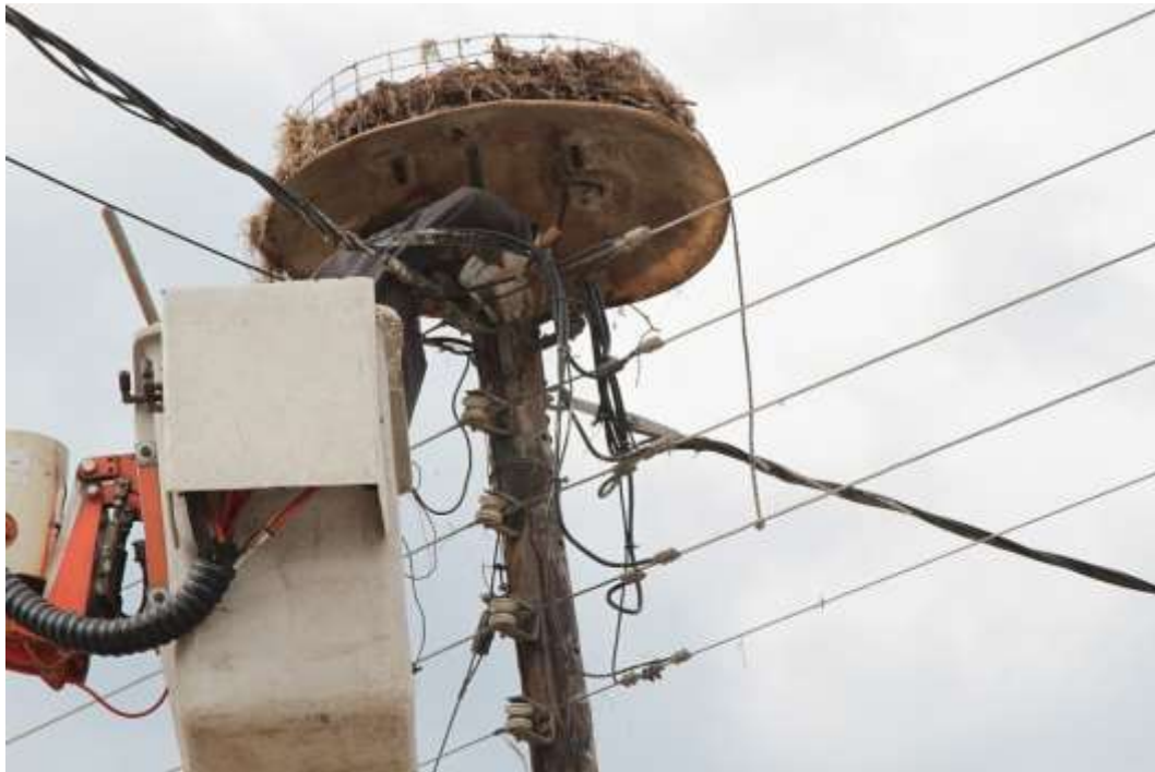
Εικ.2. Επισκευή φωλιάς στην Απολλωνία
