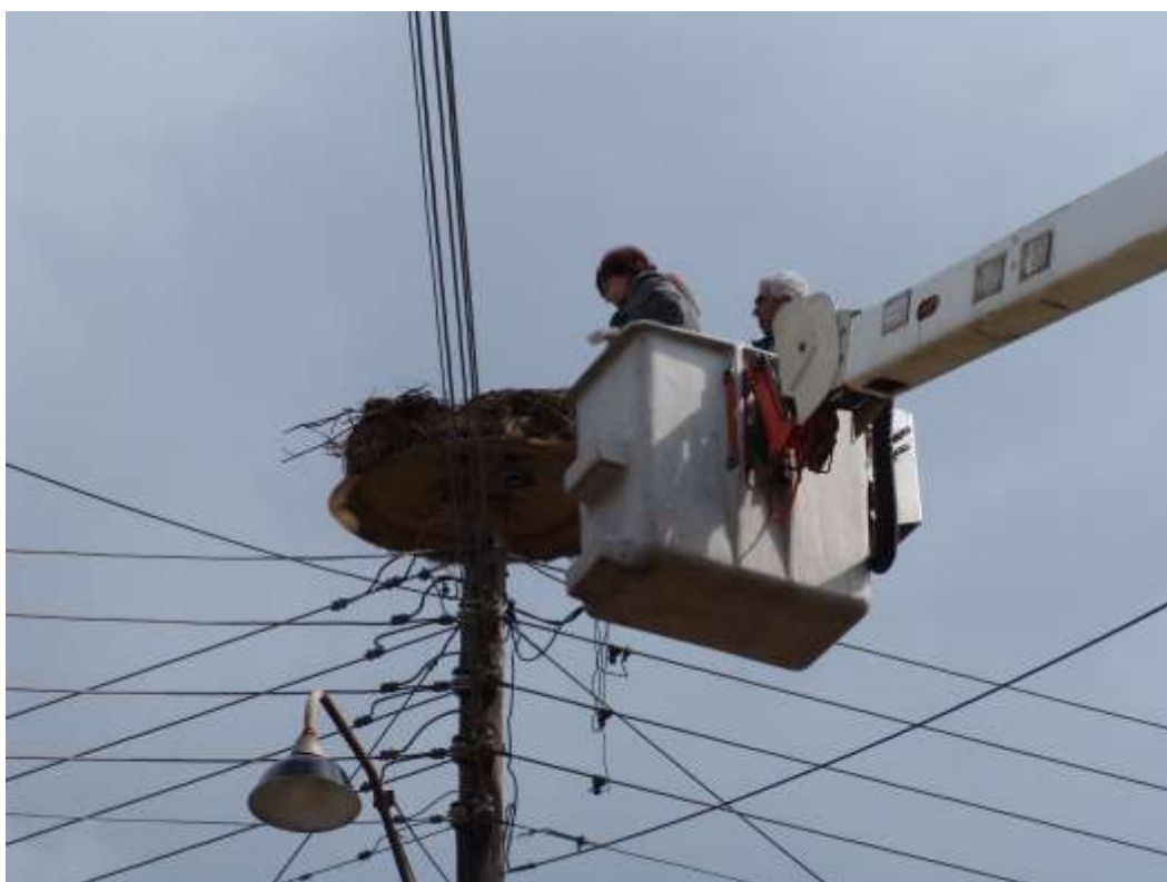
4) Τοποθέτηση αγωγών στη φωλιά
