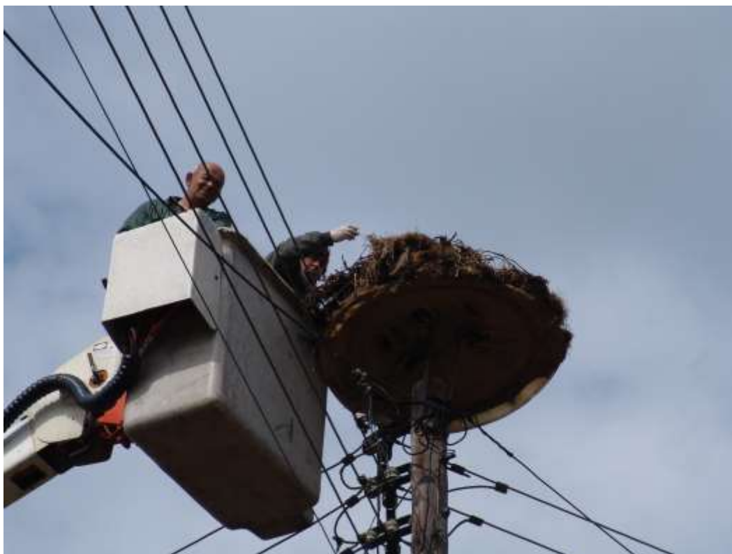
3) Τοποθέτηση αγωγών στη φωλιά
